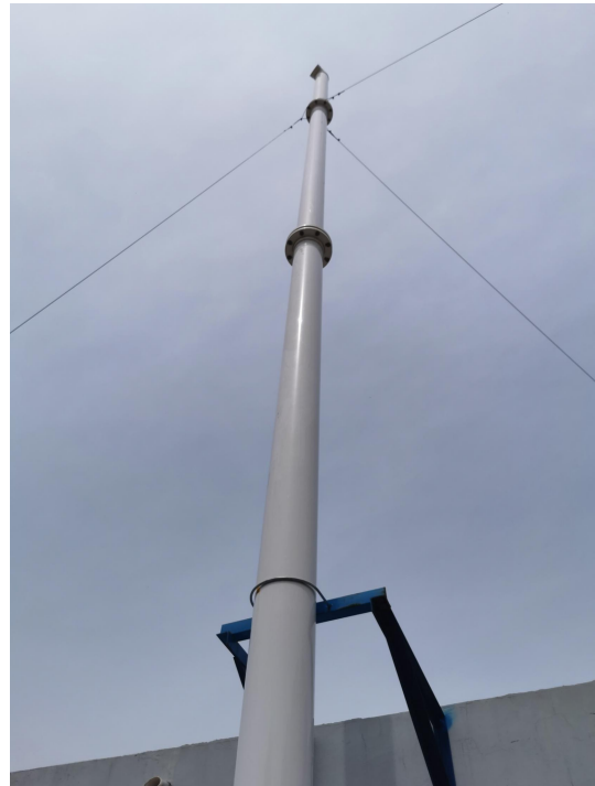
污水处理站排气筒
